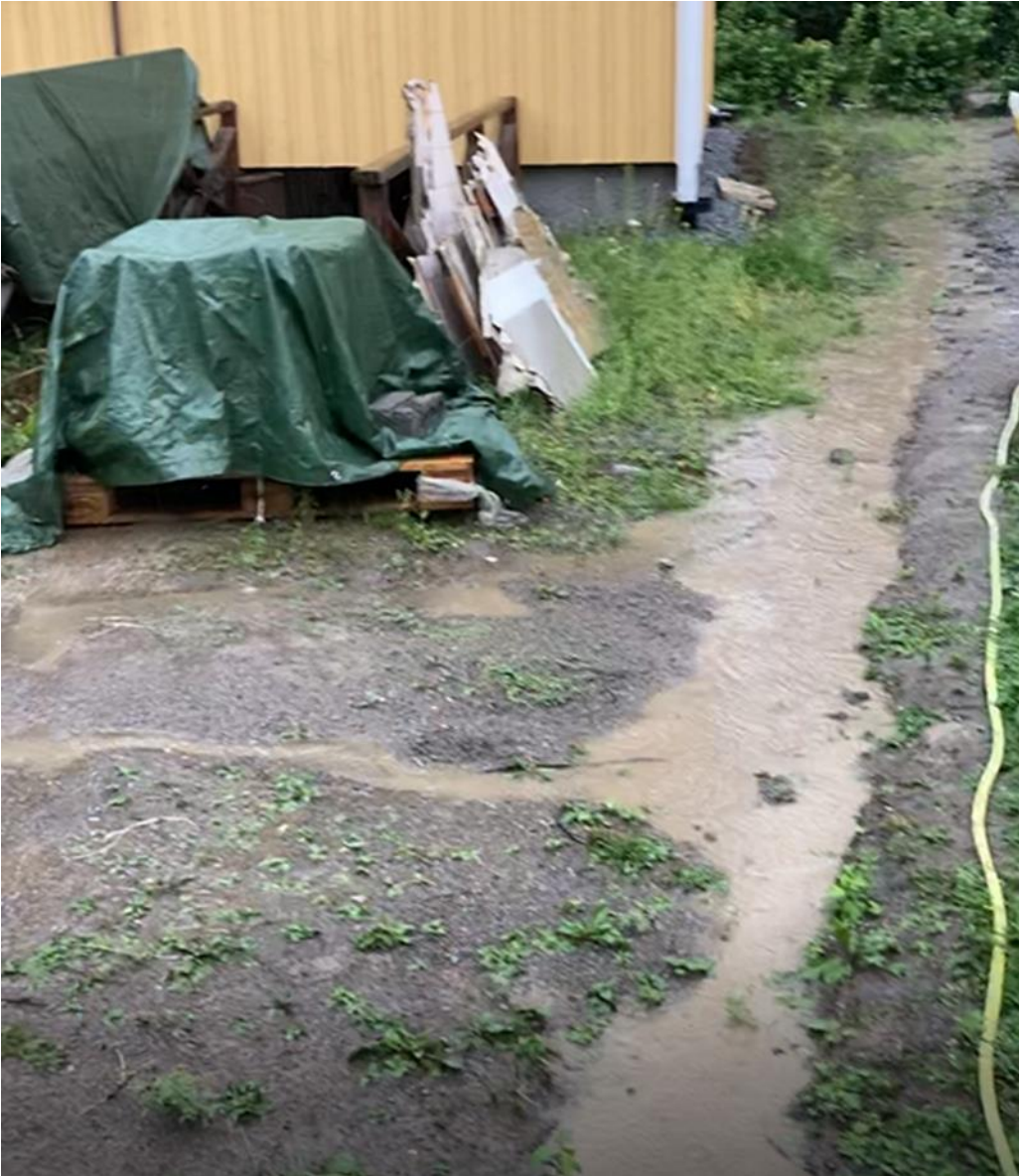
4. Tontin B pihamaalta valuu hulevesiä kohti rajaa.
